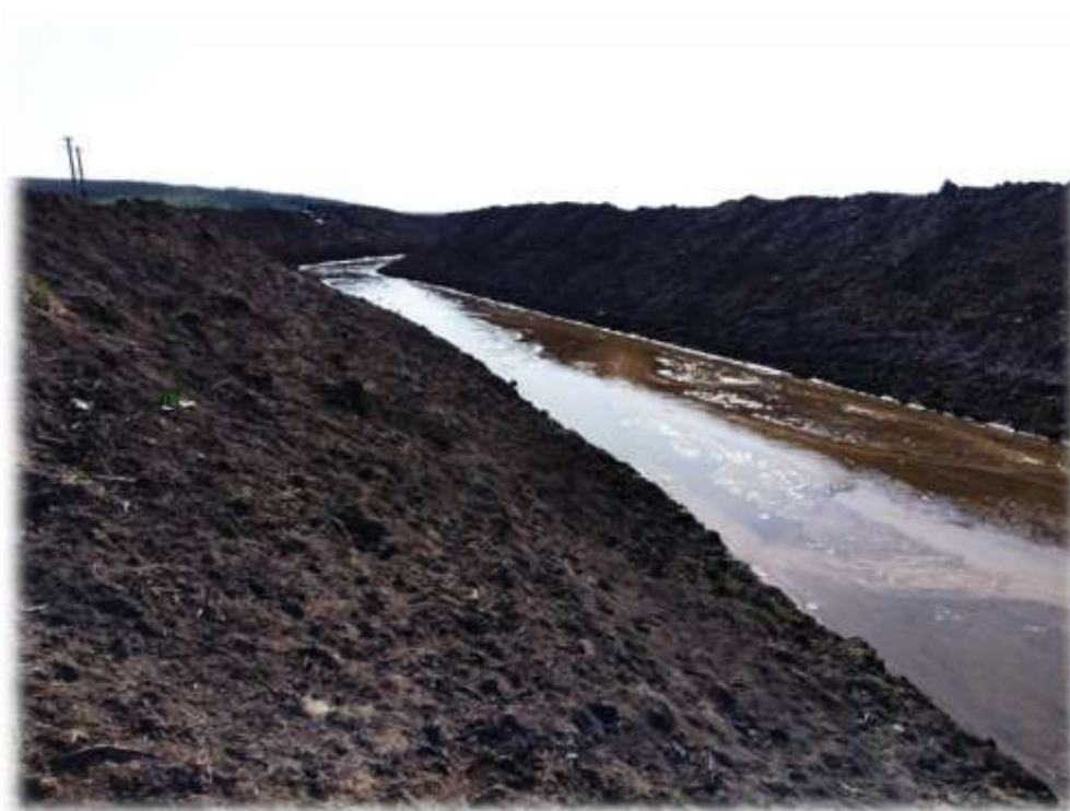
Figura nr.8. Decolmatarea pârâului Gologanu
