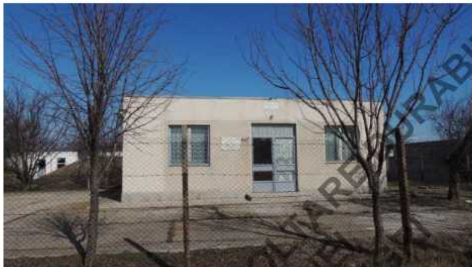
Fig. Nr. 4.33. Gospodăria de Apă a comunei Costache Negri
