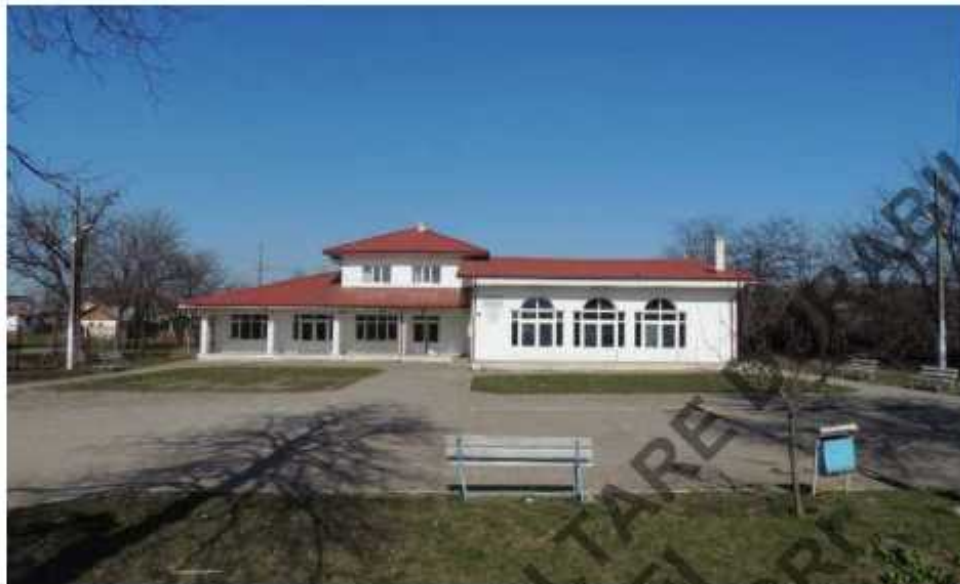
Fig. nr. 4.47. Căminul cultural din comuna Costache Negri
